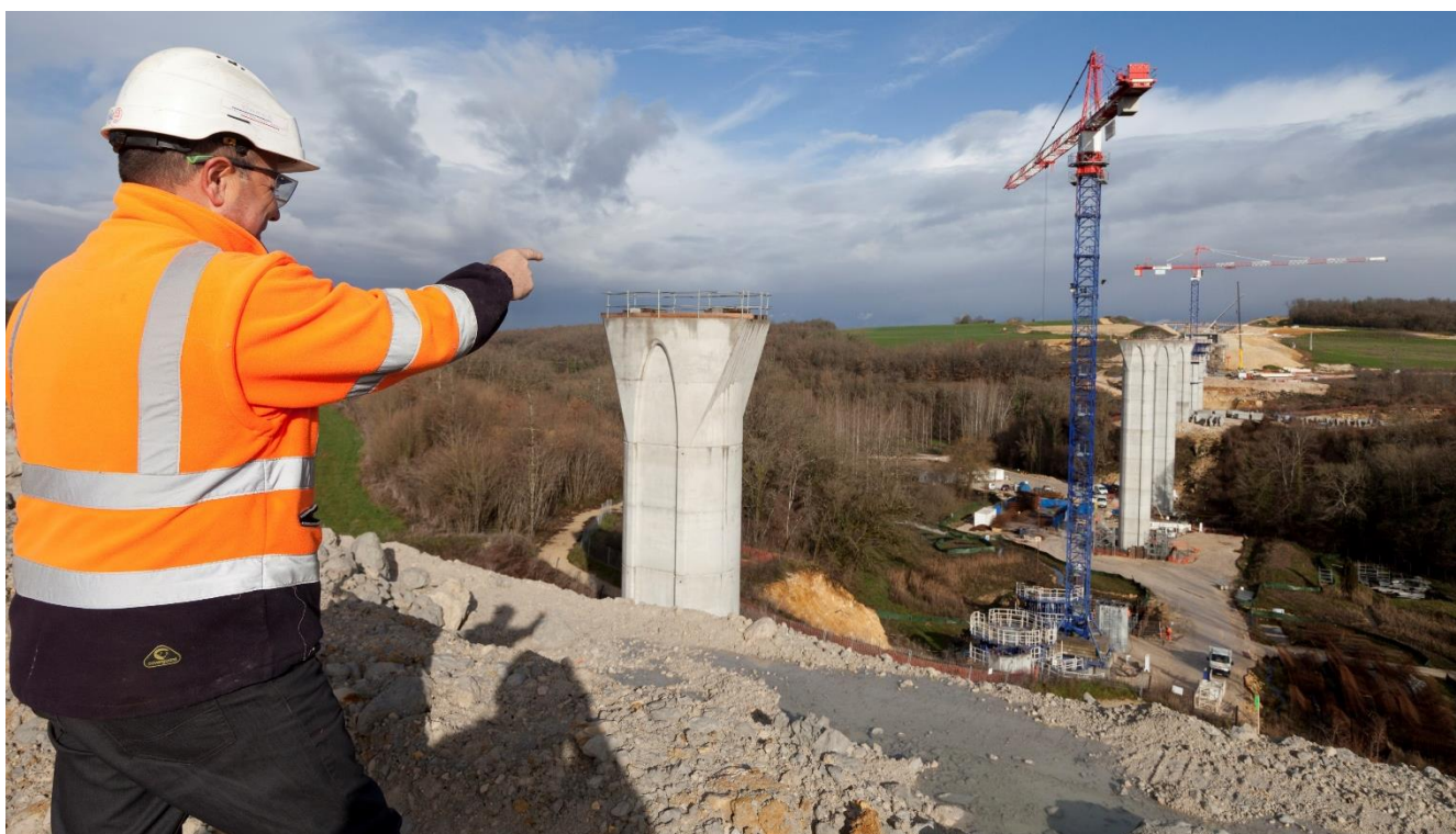
©crédit photo : Médiathèque Lafarge - Jean-Daniel Guilloux - LISEA
