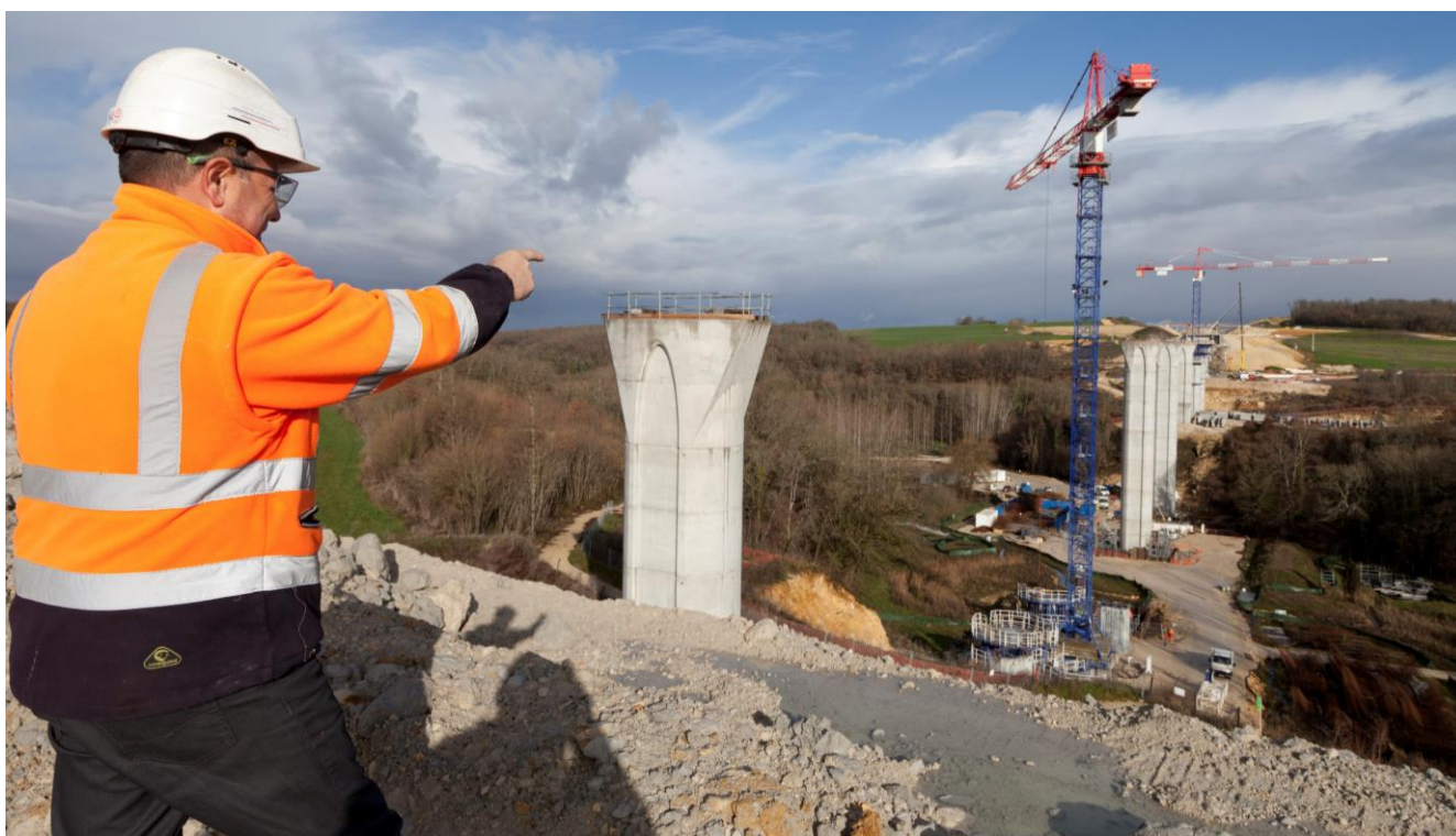
©crédit photo : Médiathèque Lafarge - Jean-Daniel Guilloux - LISEA
